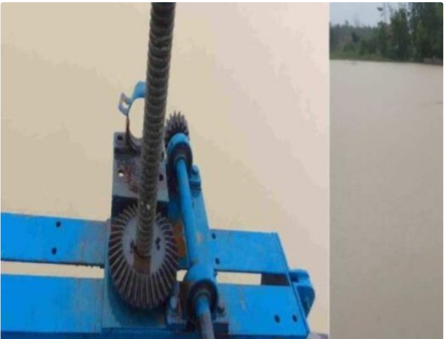
Pintu air Albaret Simpang Mesuji
