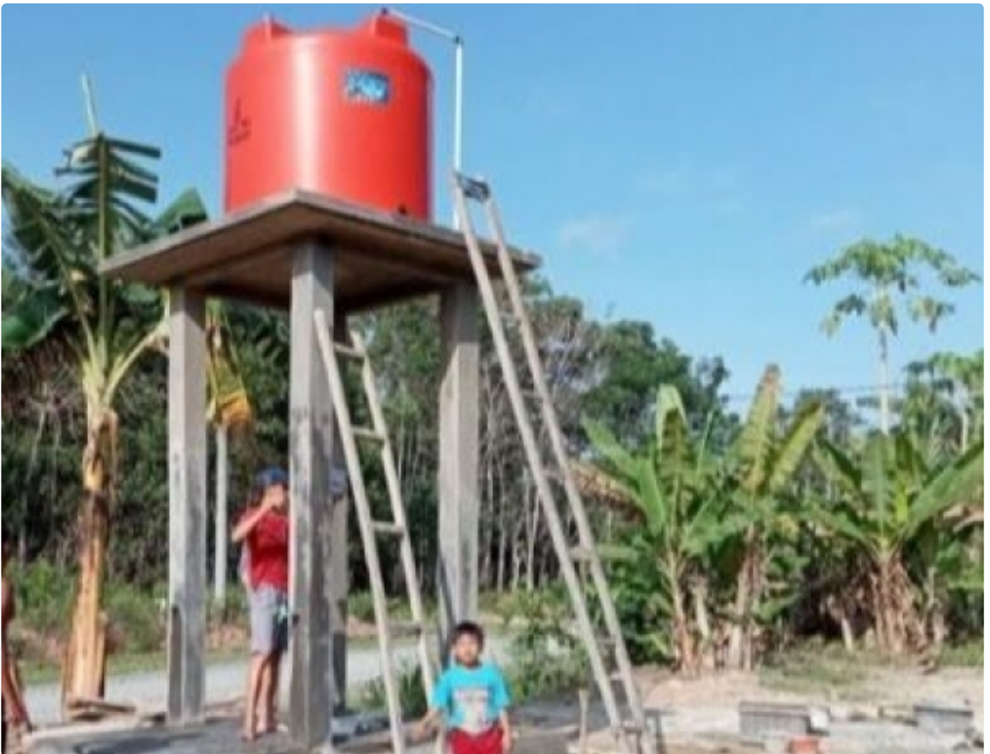
Pembangunan sumur bor di Desa Fajar Baru
